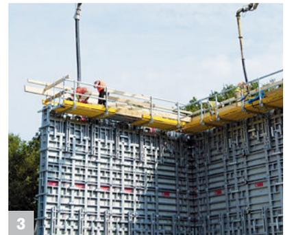
3 Uneingeschränkt schnelles Betonieren aufgrund der hohen Schalungsdruckaufnahme von 100 kN/m<sup>2</sup> im Gesamtsystem.
